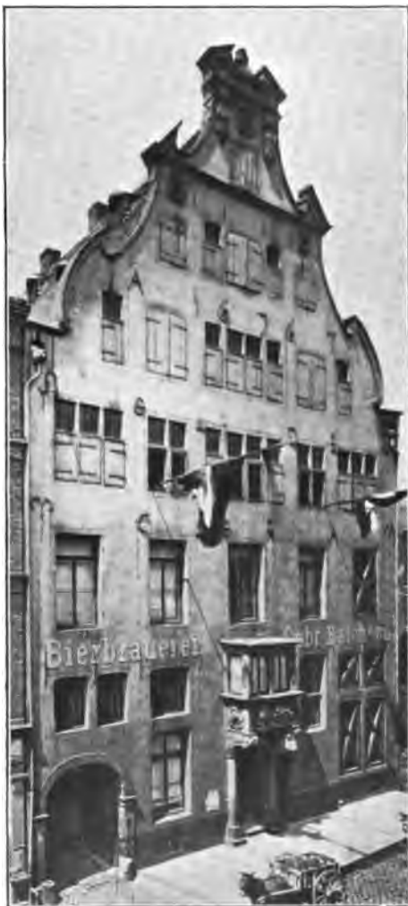
Vieille maison de la rue Saint-Séverin (1676) .
